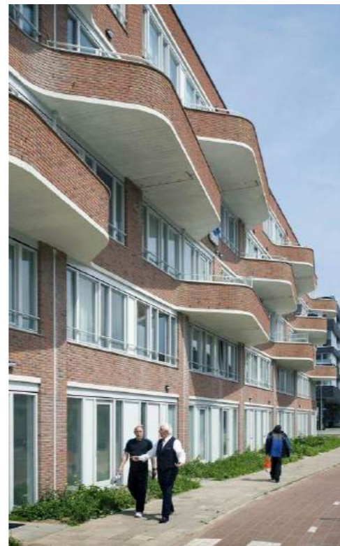
Referentie materialisatie bakstenen balkon
